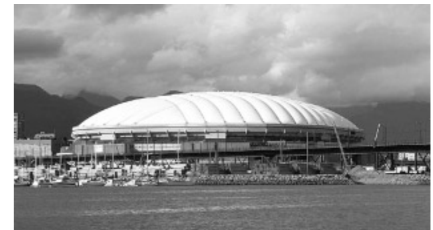
Figuur 4.4. Draagluchthal in Vancouver, Canada, gebouwd voor de Expo in 1986. De plattegrond vormt een ellips met stralen 190m en 231m
